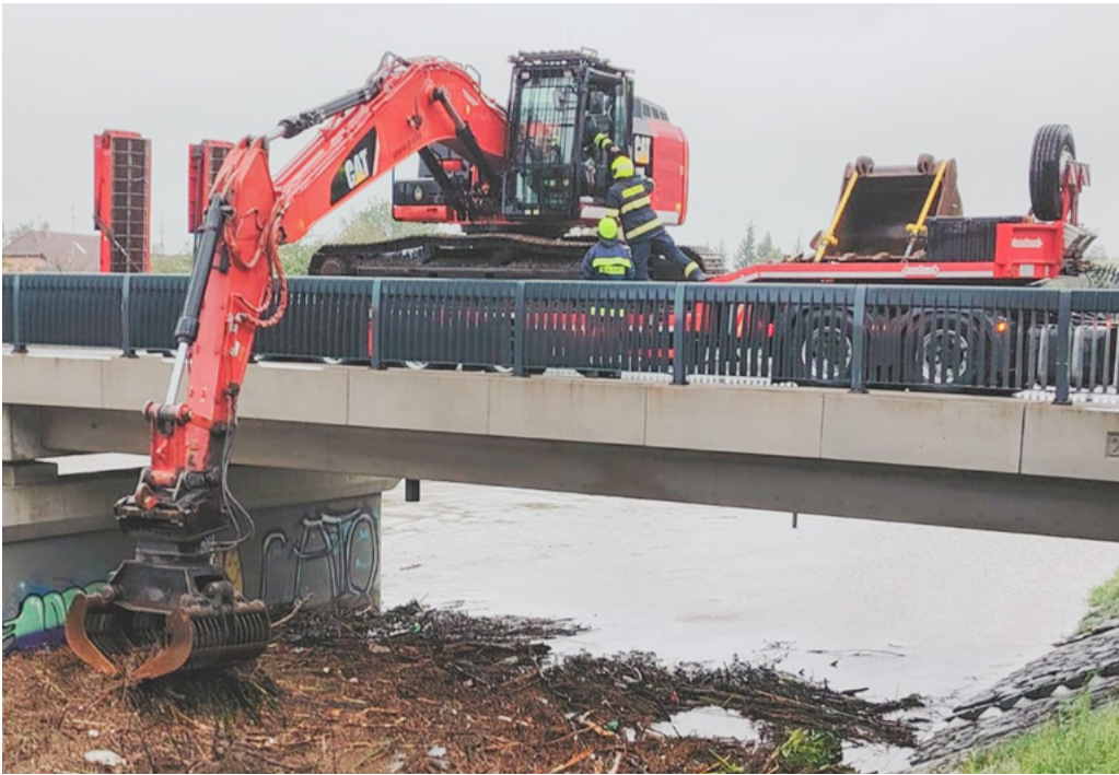
Nezastupitelnou roli v terénu, kde bylo klasické vybavení bezmocné, nahradily automobilové jeřáby, vyprošťovací automobily a vyprošťovací tanky. Ty byly nasazeny primárně na odstraňování stržených lávek a mostních konstrukcí z vodních zdrojů a komunikací. Fota: archiv Záchranného útvaru HZS ČR
