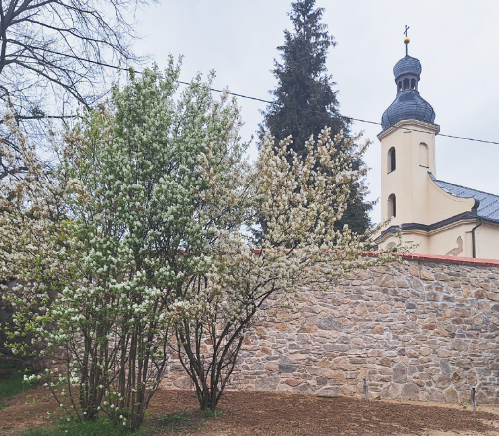
Opravená zeď u kostela sv. Markéty. Foto: Kateřina Konečná
