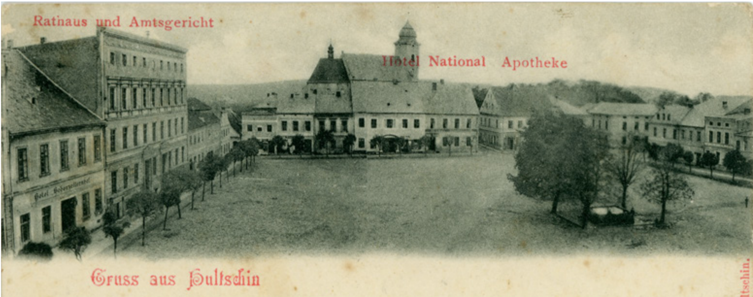
Symbolem modernity se v Hlučíně stala nová radnice, která byla postavena v šedesátých letech 19. století. Budova v době svého vzniku převýšila dosavadní výškovou hladinu domů na náměstí o několik etáží a doslova vyčnívala. Vzácná dobová pohlednice dokumentuje podobu zástavby před postavením činžovního domu, ve kterém dnes sídlí budova B městského úřadu. (sbírka Waltra Kozuba)
