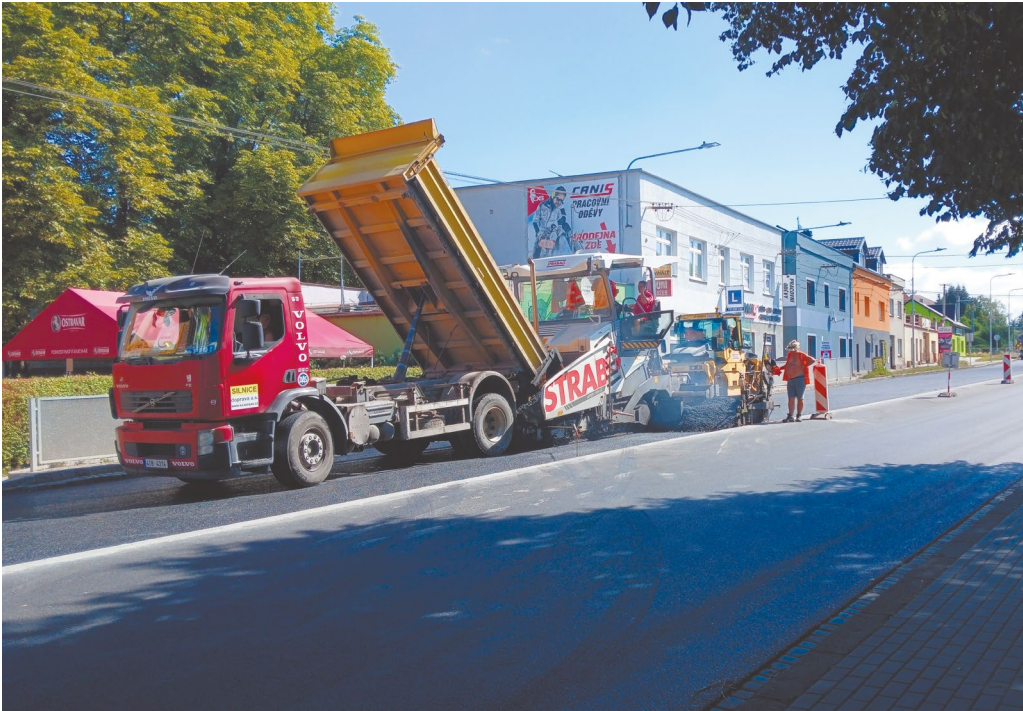
Přes léto se podařilo opravit průtah městem. Foto: archiv MÚ Hlučín
