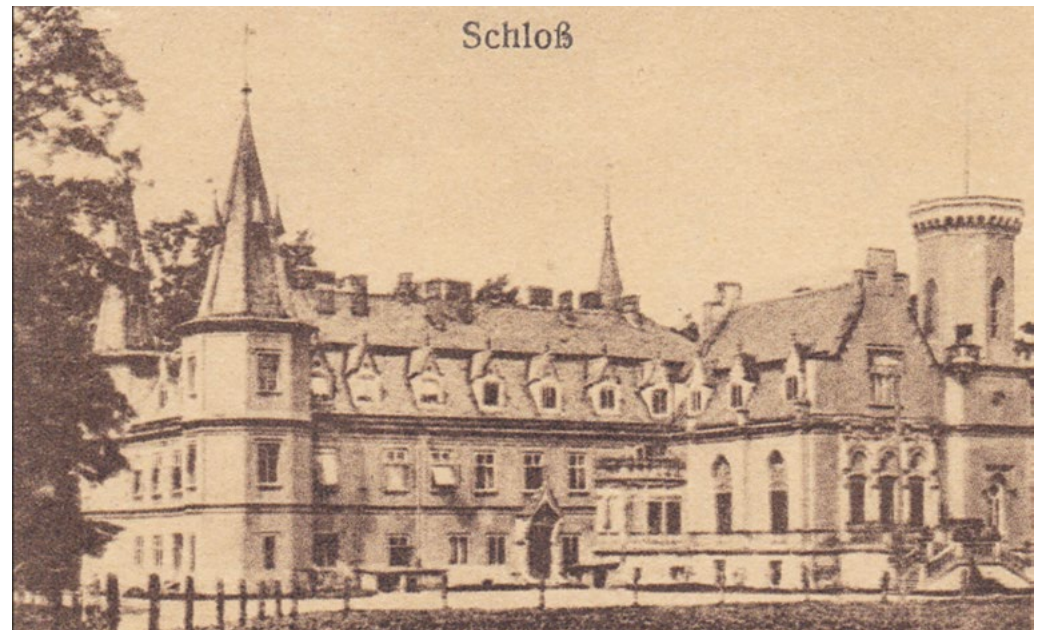
Novogotická podoba zámku v Křižanovicích na výřezu z dobové pohlednice (soukromá sbírka)
