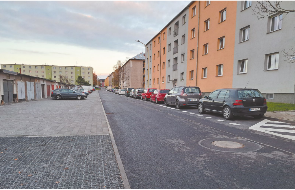
Opravy v Severní ulici jsou hotové. Foto: MÚ Hlučín
