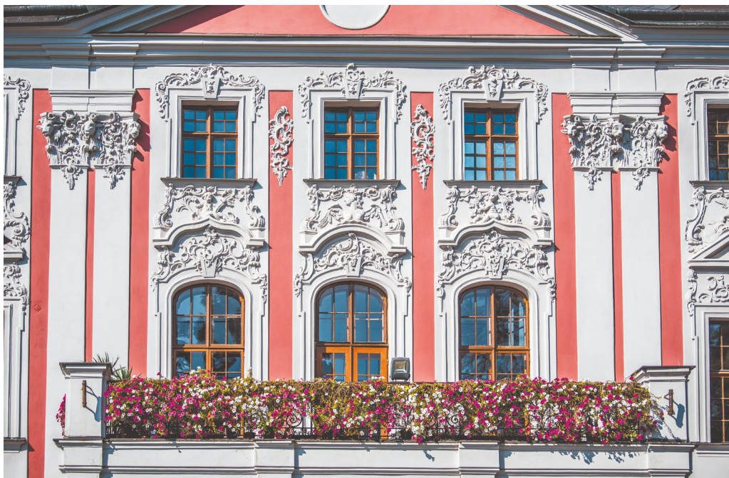
Detail barokní fasády velkohoštického zámku.
