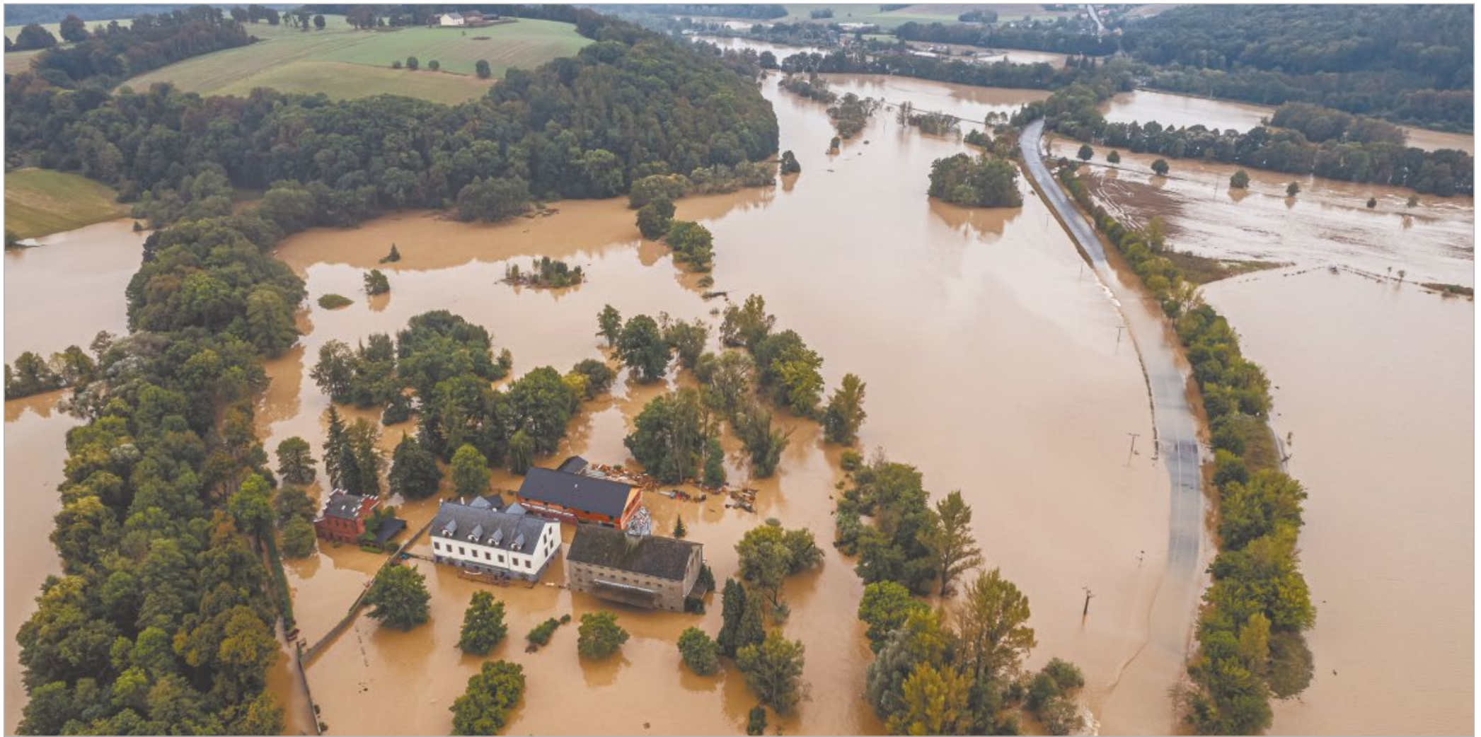
Voda dokáže napáchat obrovské škody. Přesvědčit jsme se o tom mohli i v Hlučíně. Foto: Kamil Vításek
