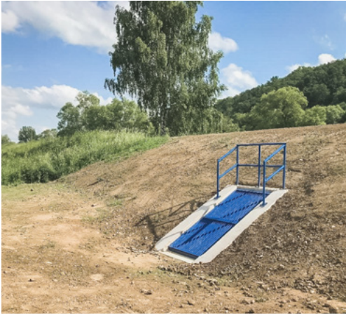
Pravobřežní hráz - propustek v části Děhylov.
