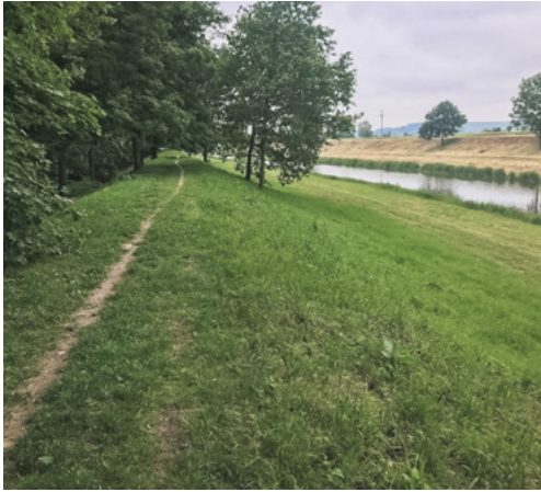
Pravobřežní hráz - kosení. Fota: archiv Gardenline s.r.o.
