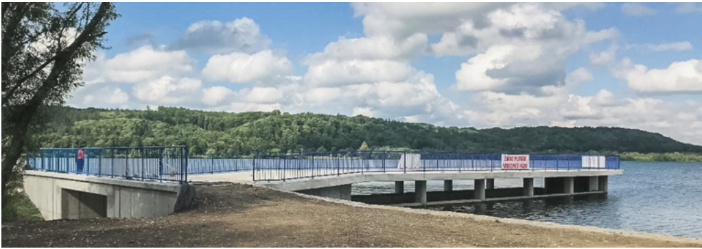
Bezpečnostní přeliv s přemostněním.
