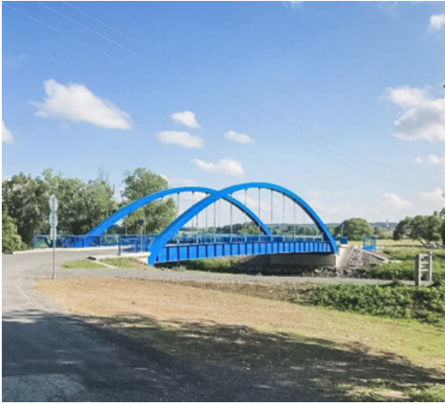
Rekonstrukce mostu přes řeku Opavu - Jilešovice.
