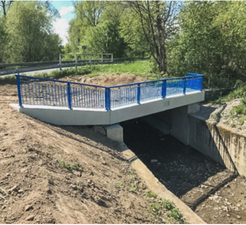
Úprava stávajícího mostního objektu - Hlučín.
