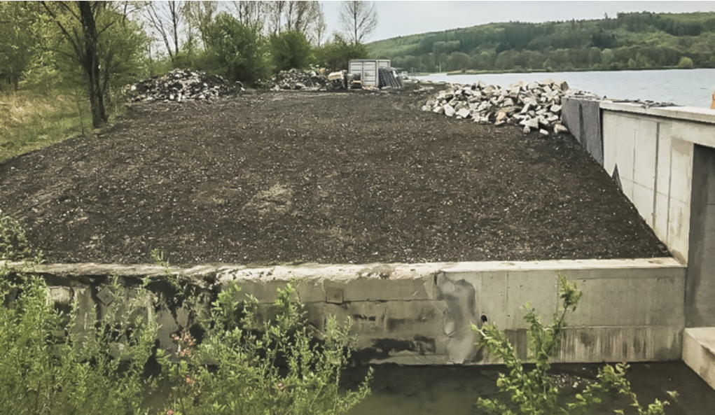
Bezpečnostní přeliv - přemostění.
