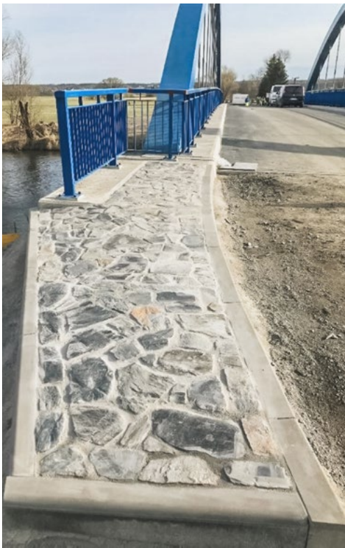
Most přes řeku Opavu – položeni obrubníků a dlažby. Fota: archiv Gardenline s.r.o.
