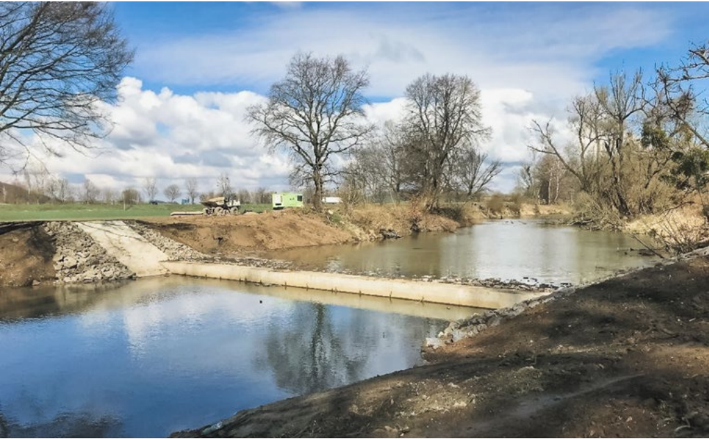
Koryto bezpečnostního přelivu – výškový stupeň.
