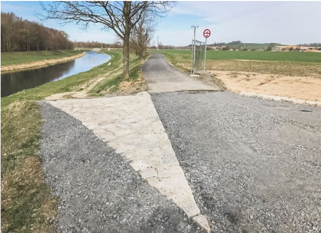
Levobřežní hráz – sjezd a napojení cyklostezky na stávající komunikaci.
