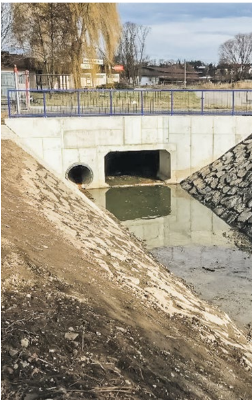
Úprava potoka Vařešinka – zkapacitnění zatrubněné části – odtok.
