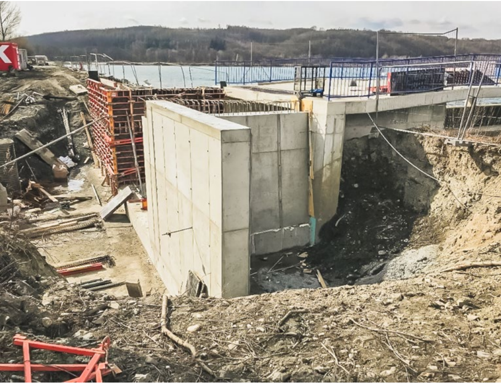
Bezpečnostní přeliv - přemostění.
