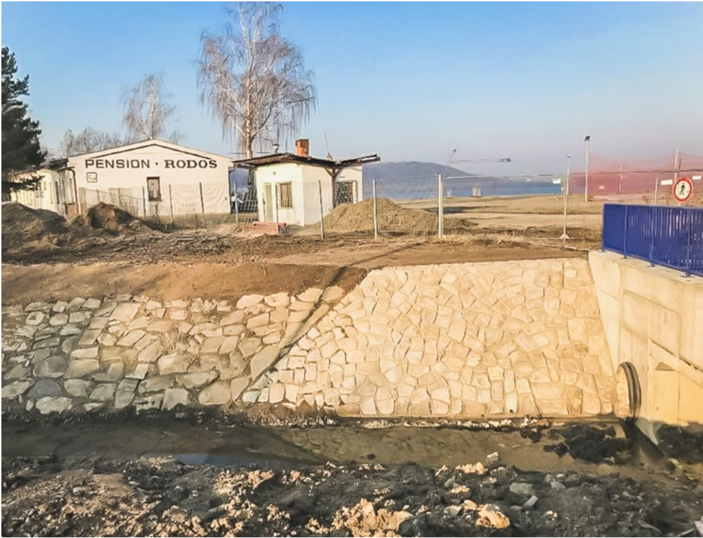
Úprava potoka Vařešinky - opevnění břehů. Fota: archiv Gardenline s.r.o.
