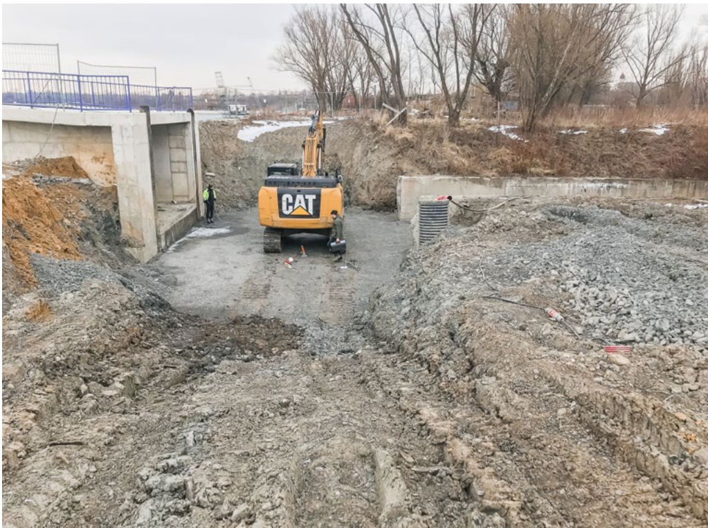
Bezpečnostní přeliv – přemostění – příprava základové konstrukce.
