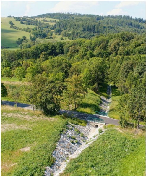
Realizace protierozního opatření v Budišově nad Budišovkou.
