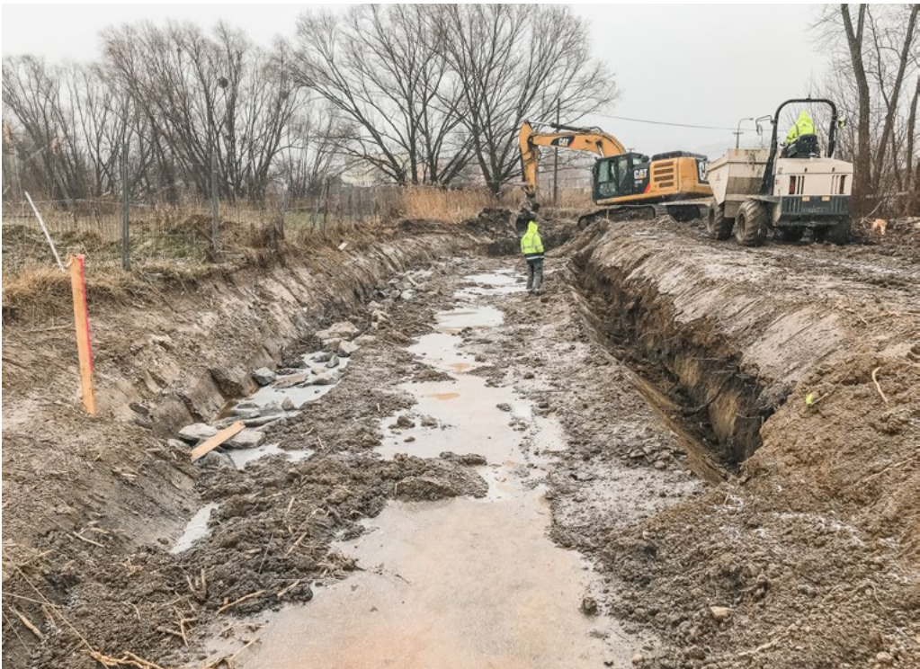
Úprava potoka Vařešinky – úprava a zkapacitnění koryta.
