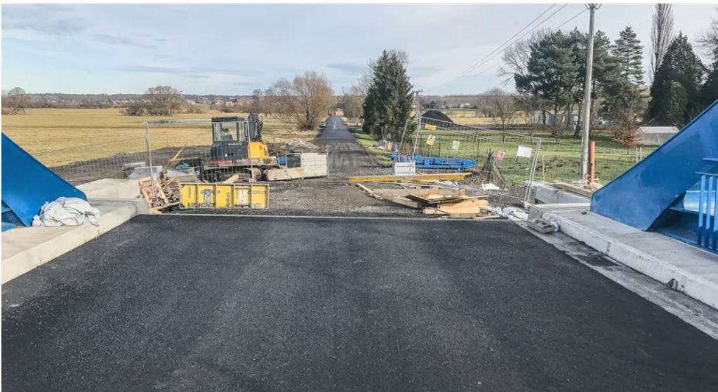
Most přes řeku Opavu - úprava komunikace Jilešovice - Kozmice. Fota: archiv Gardenline s.r.o.
