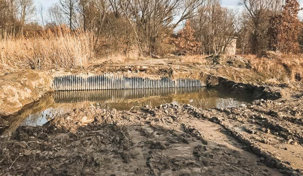
Úprava koryta Vařešinky - vybourání stávajícího propustku.
