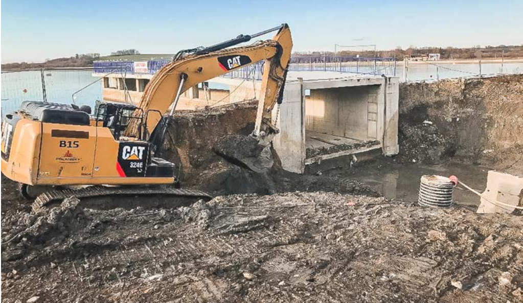
Přemostění u bezpečnostního přelivu.
