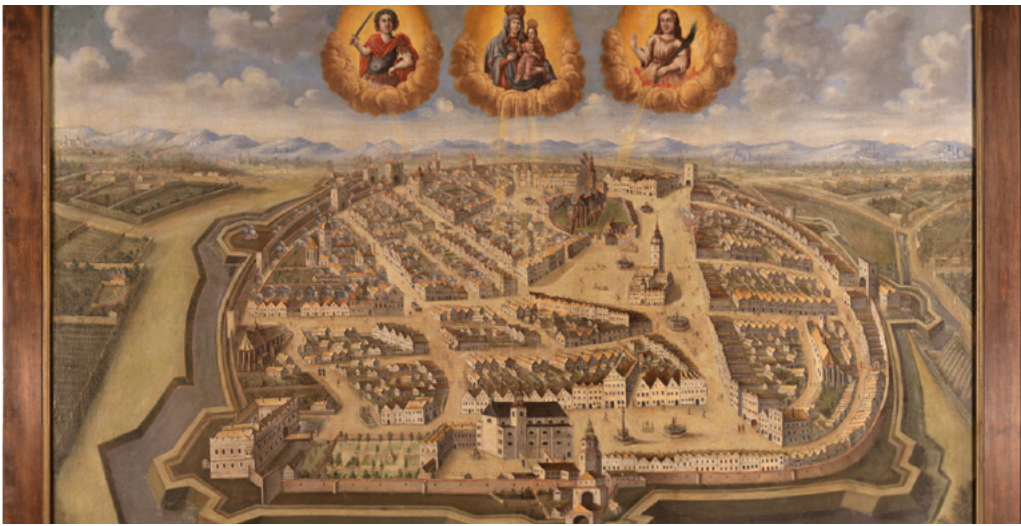
Struktura středověkého města většinou přetrvává do současnosti. Ačkoliv drtivá většina původních domů již neexistuje, zachoval se uliční systém a některé církevní objekty. Názorně to dokládá Požární obraz Opavy. (SZM)
