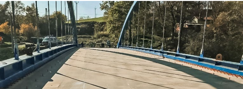
Další práce pokračují na předpolích a mostním vybavení - zábradlí, schodiště apod.
