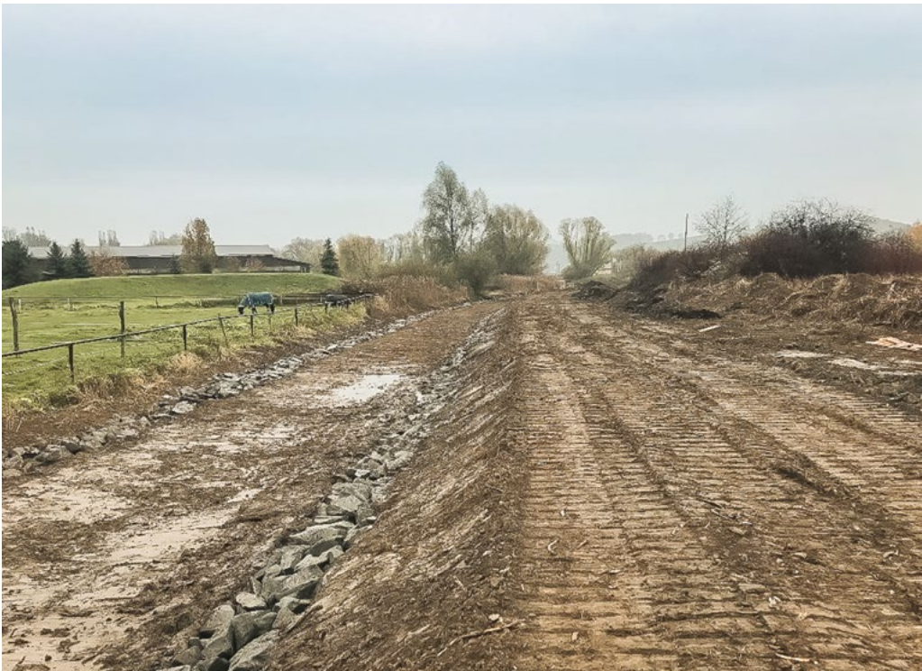
Úprava koryta potoku Vařešinky. Fota: Gardenline s.r.o.
