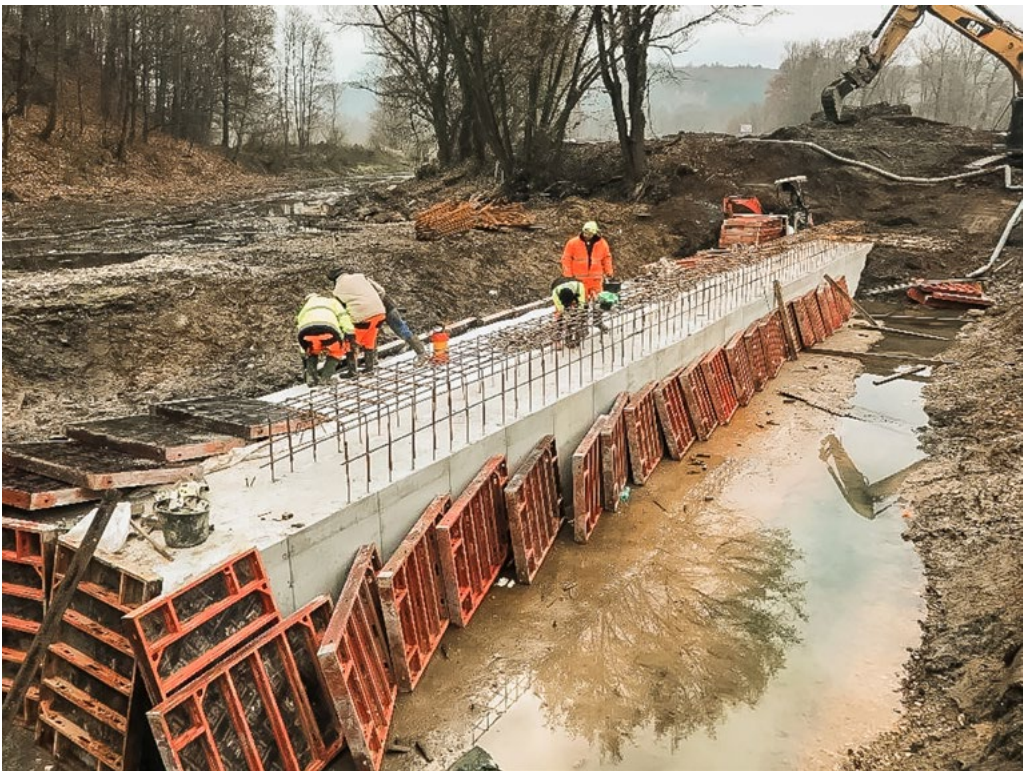
Koryto bezpečnostního přelivu - výškový stupeň.
