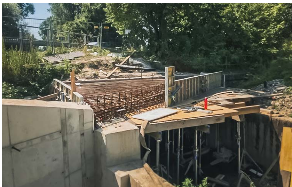
Úprava stávajícího mostního objektu.
