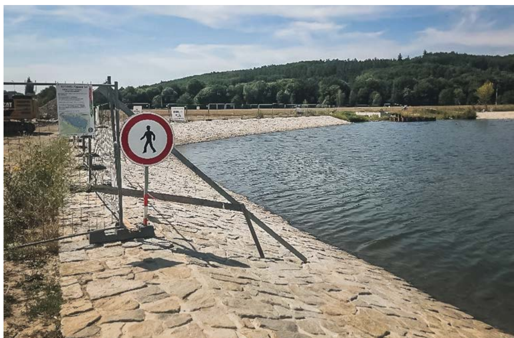
Výpustný objekt. Fota: Gardenline s.r.o.
