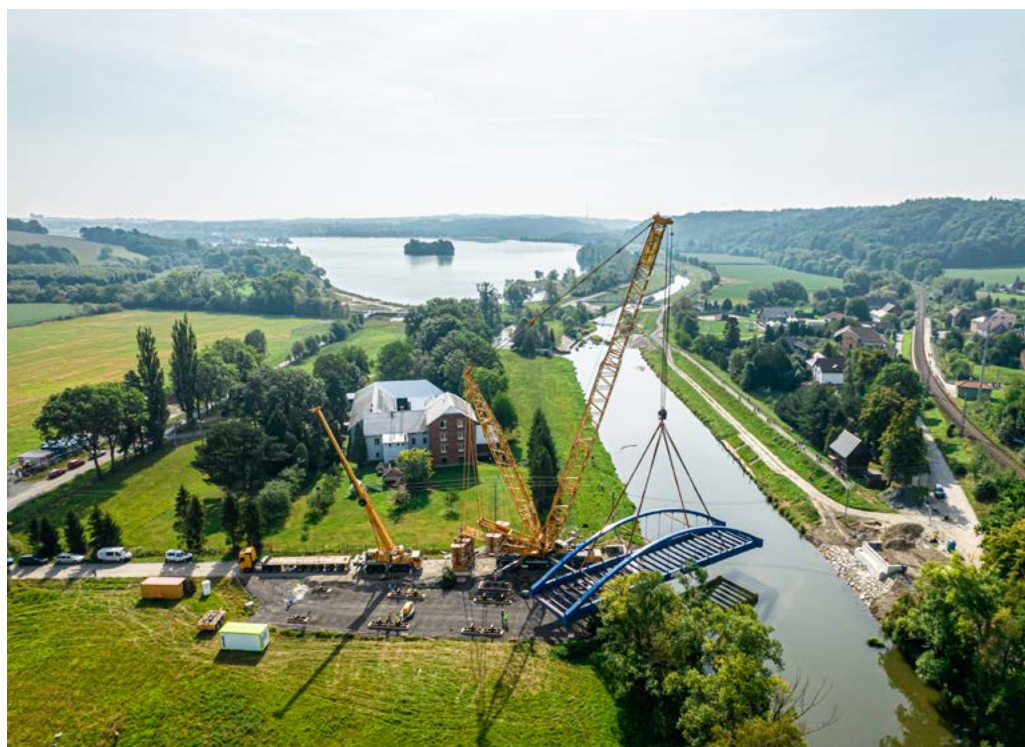
Instalace nového mostu přes řeku Opavu. Foto: Kamil Vitásek
