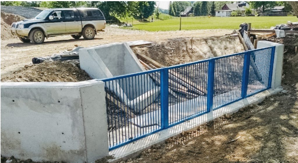
Hrázová propust na pravobřežní hrázi - česlová stěna.
