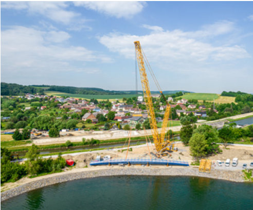
Práce na březích Hlučínského jezera.
