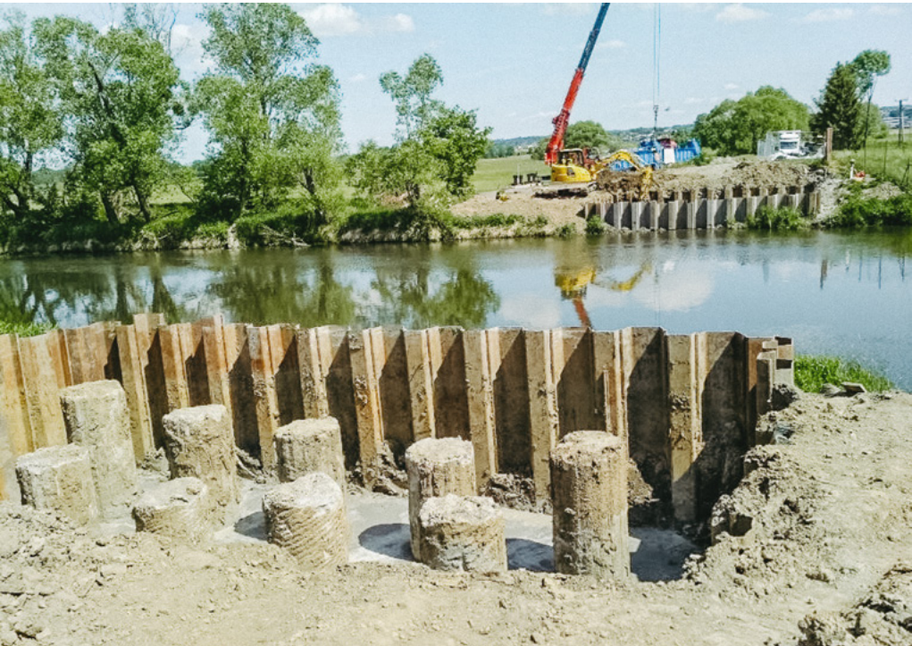
Most přes Opavu z Kozmic do Jilešovic - piloty základových opěr Fota: archiv Gardenline s.r.o.
