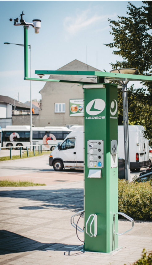
Dobíjecí stanice na autobusovém nádraží.
