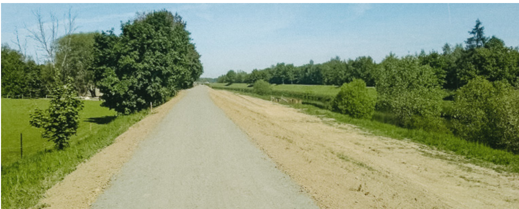
Pravobřežní hráz - finální úprava povrchu hráze.
