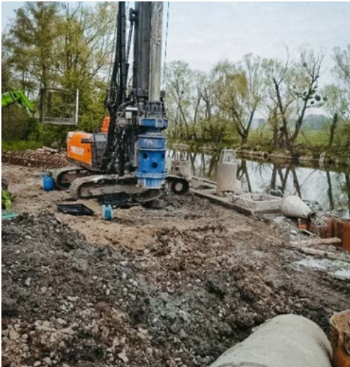
Most z Kozmic do Jilešovic - vrtání pilot
