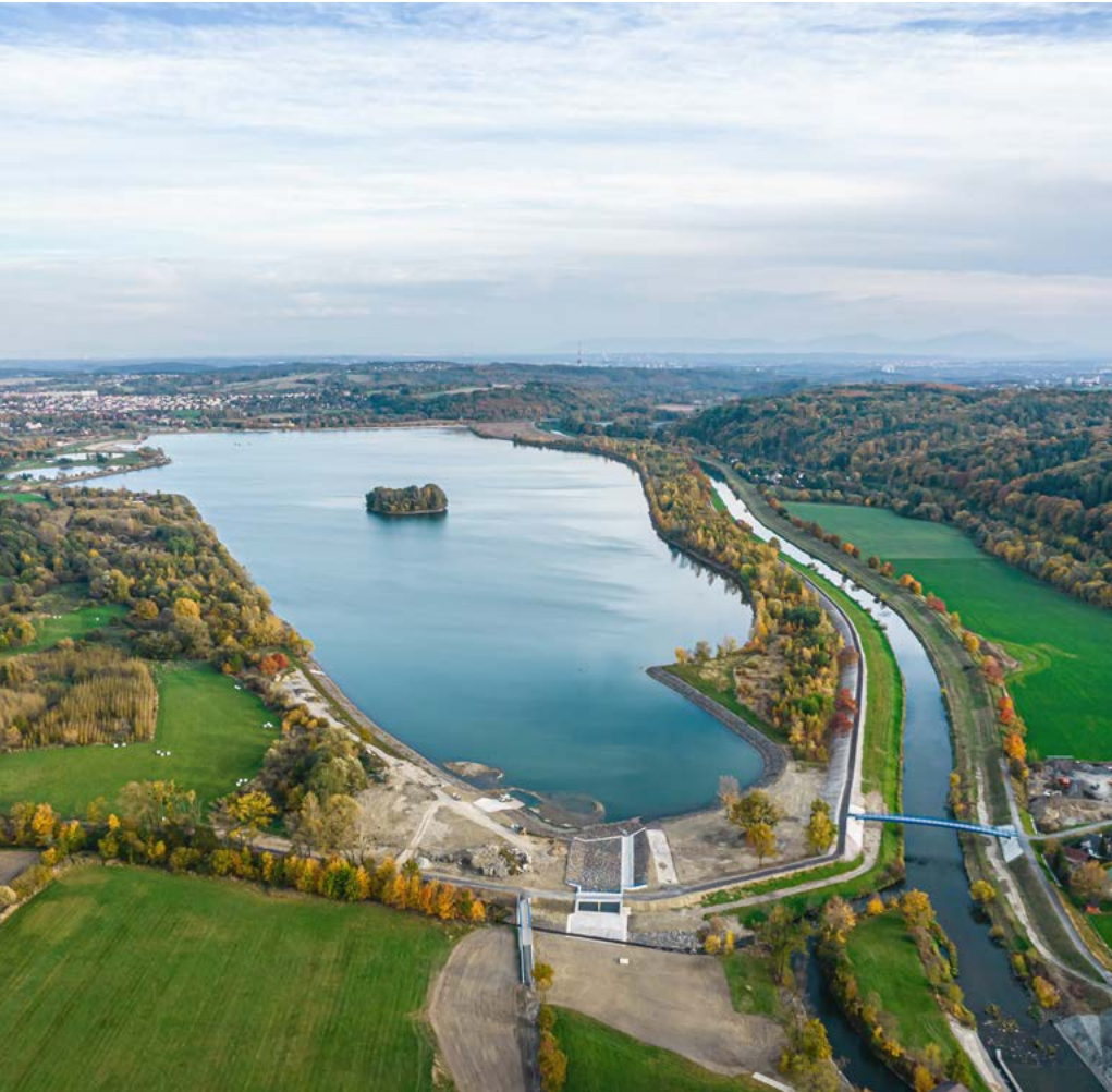
Práce na jezeře, r. 2021. Foto: Kamil Vitásek
