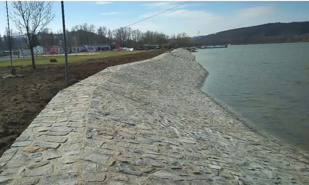
Sportovně rekreační areál - opevnění břehů.
