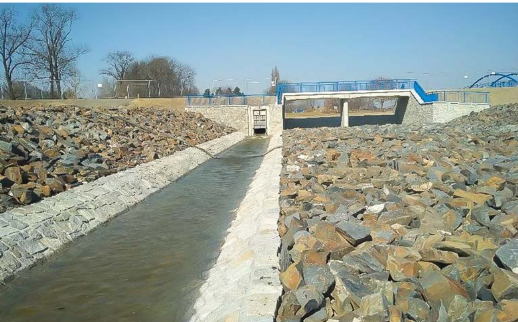
Funkční objekt - napouštění Hlučínského jezera. Fota: archiv Gardenline s.r.o.
