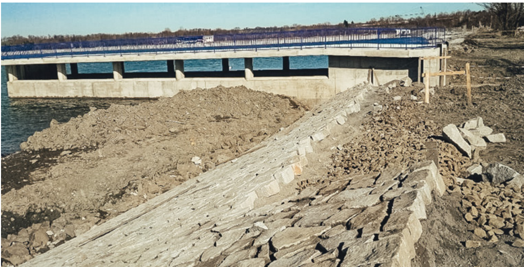
Opevnění břehů - pokládka kamenné dlažby kolem bezpečnostního přelivu. Fota: archiv Gardenline s.r.o.
