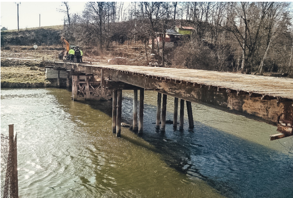
Most z Kozmic do Jilešovic - demontáž stávající konstrukce.
