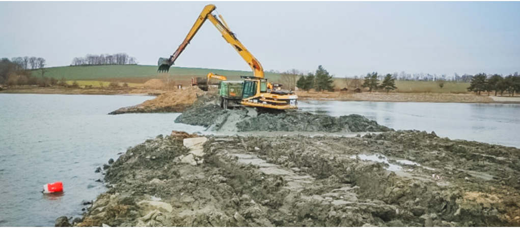
Odkop hráze mezi Hlučínským jezerem a „novou“ zátokou.
