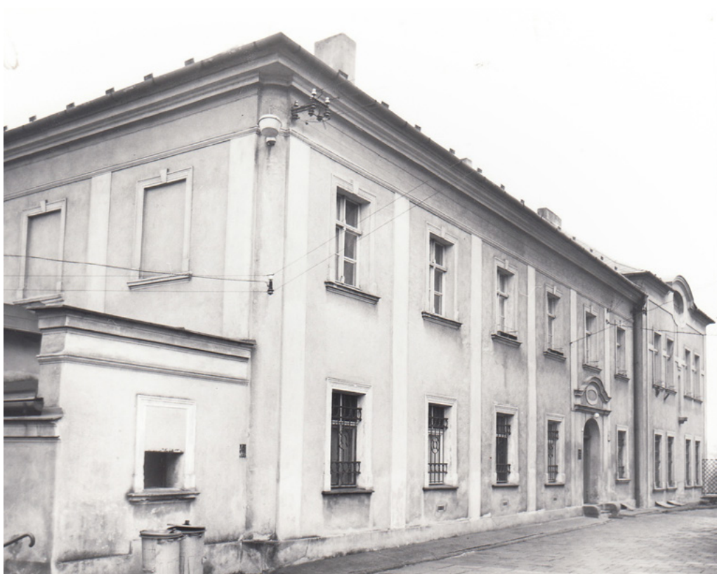
Budova farního úřadu, kde byl umístěn okresní archiv.
