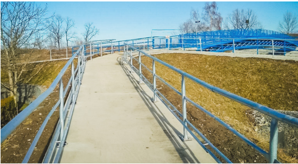
Rampa pro pěši u lávky přes řeku Opavu. Fota: archiv Gardenline s.r.o.
