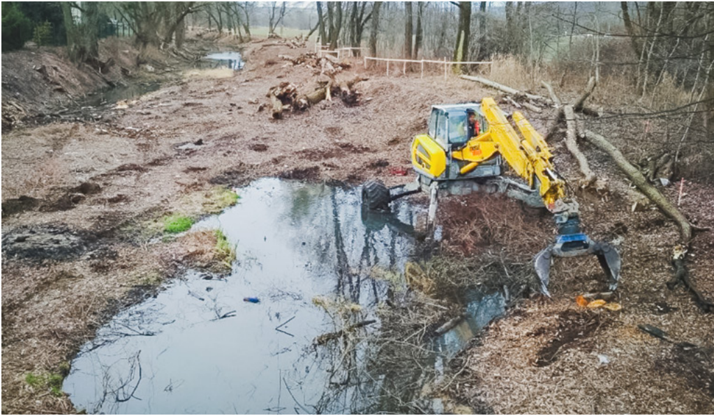
Čištění a úprava koryta bezpečnostního přelivu.
