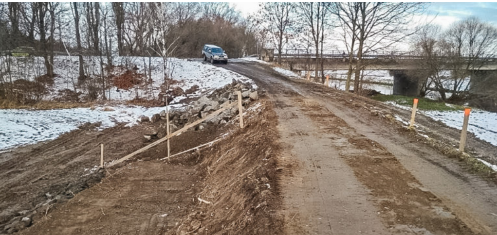
Pravobřežní hráz - navýšení a zpevnění koruny hráze.
