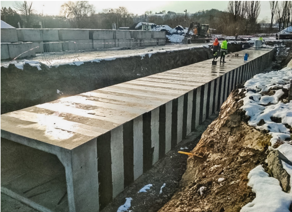
Úprava potoka Vařešinky - zkapacitnění zatrubněné části. Fota: archiv Gardenline s.r.o.
