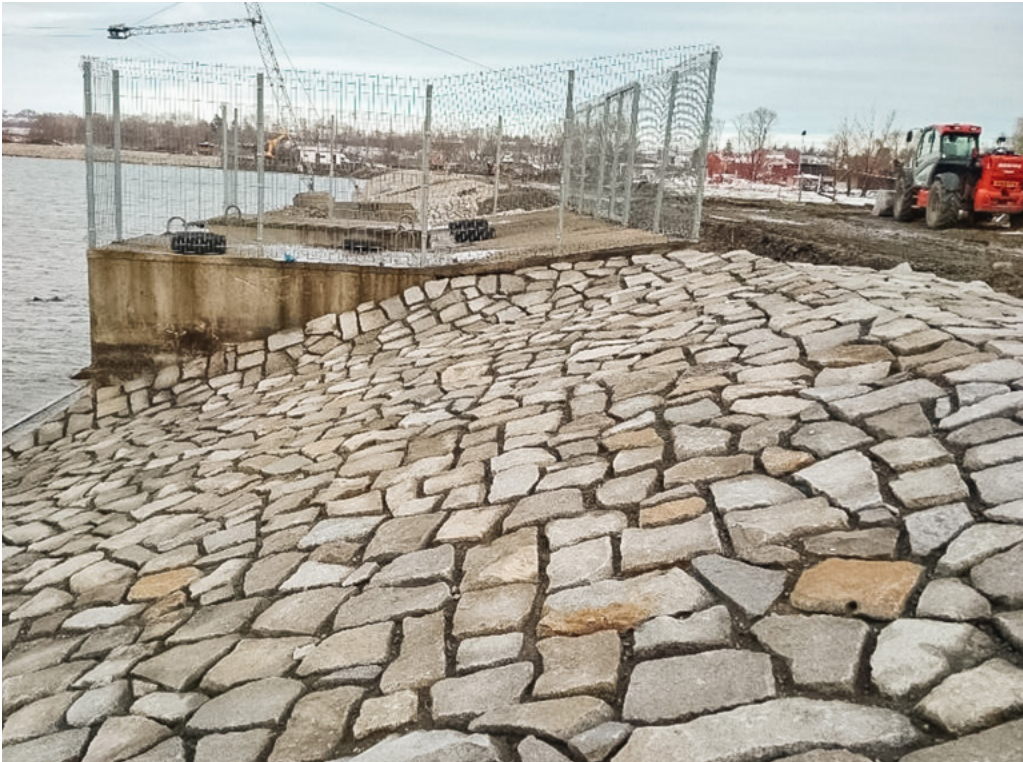
Opevnění břehů kamennou dlažbou.
