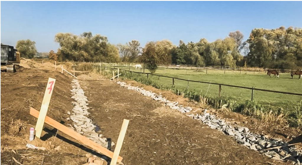
Úprava potoka Vařešinky – zkapacitnění koryta potoka. Fota: archiv Gardenline s.r.o.
