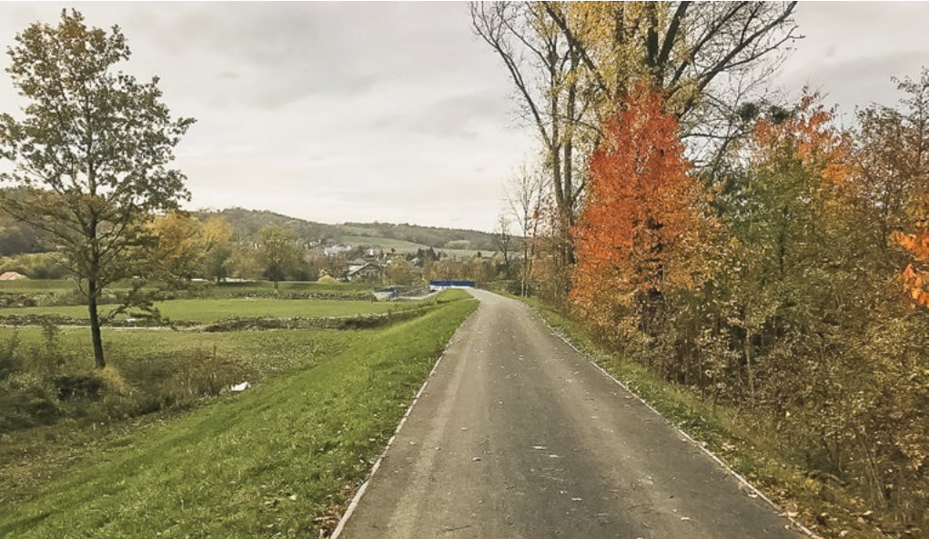
Čelní hráz a prostor mezideponie – úprava terénů a setí trávy.
