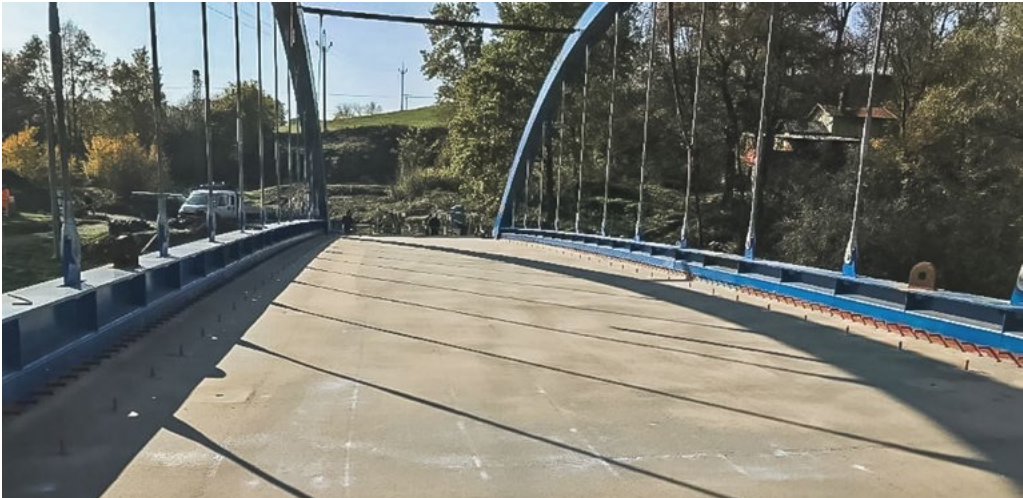
Most přes řeku Opavu – izolace a ochrana nosného povrchu.
