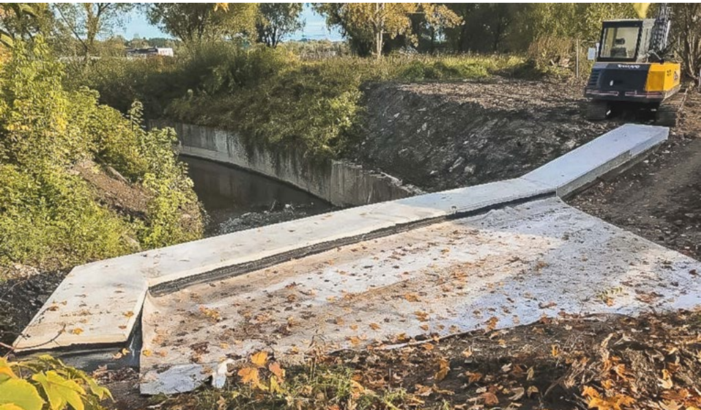
Úprava stávajícího mostního objektu.
