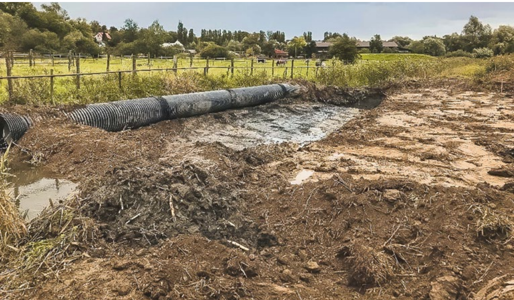
Úprava potoka Vařešinky - zatrubněné převedení vody. Fota: archiv Gardenline s.r.o.
