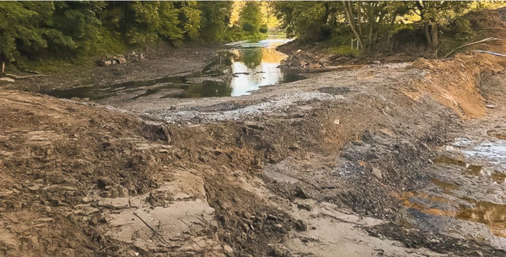
Koryto bezpečnostního přelivu - výškový stupeň.
