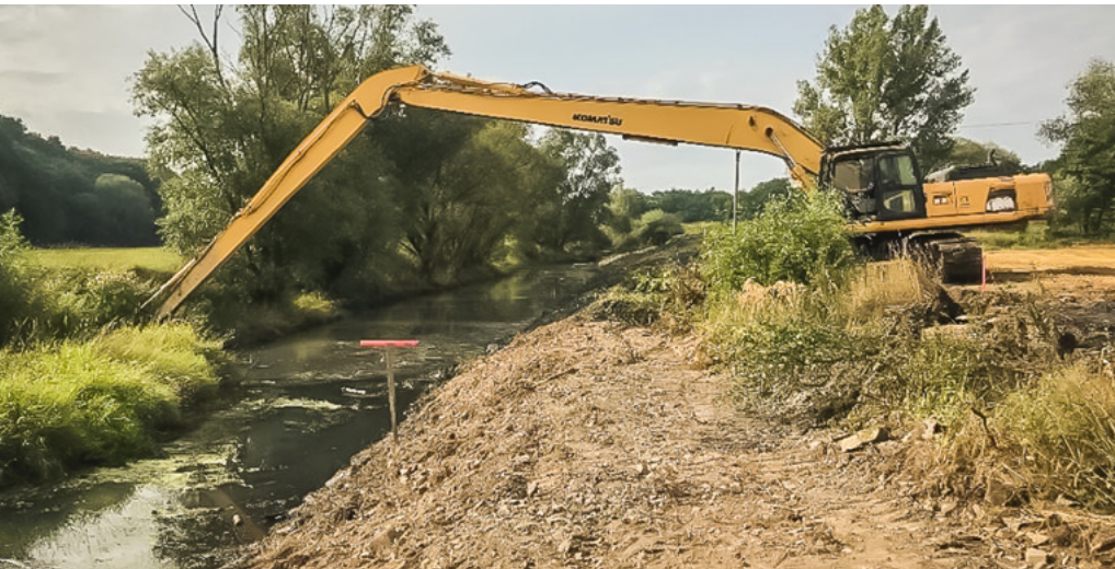
Koryto bezpečnostního přelivu - úprava koryta.
