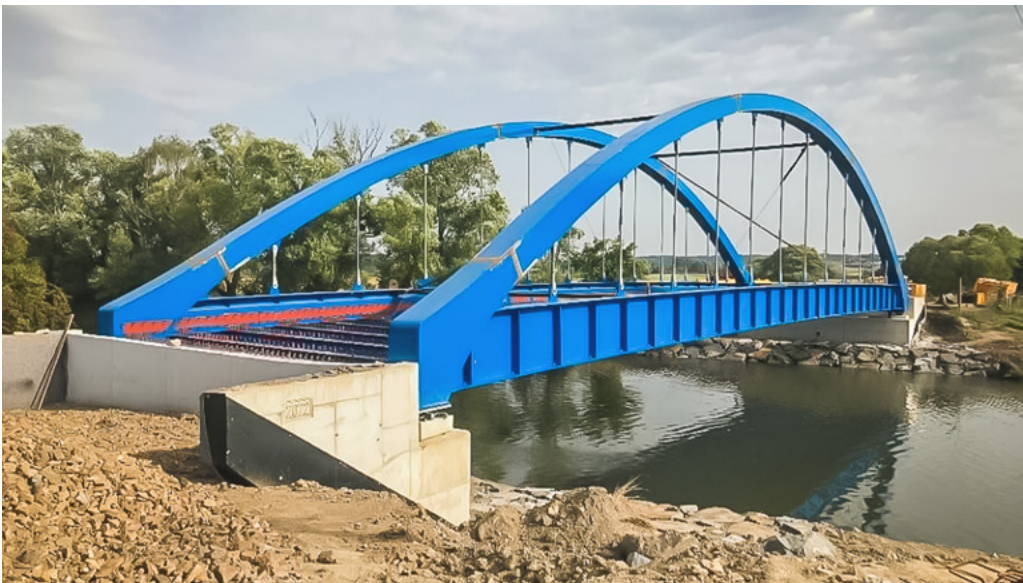
Most přes řeku Opavu.
