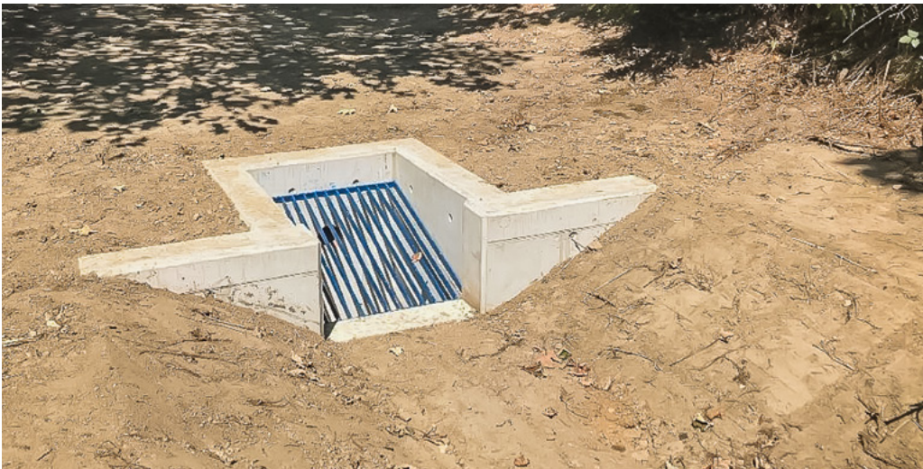
Horská vpust' – odvodňovací příkop v chatové oblasti „Rybárna“. Fota: Gardenline s.r.o.
