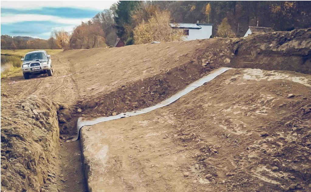
Pravobřežní hráz - pokládka geosyntetické bentonitové rohože. Fota: archiv Gardenline s.r.o.
