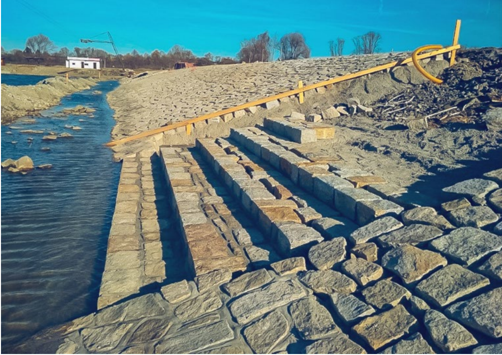
Areál Hlučínského jezera - opevnění břehů a schody do jezera.
