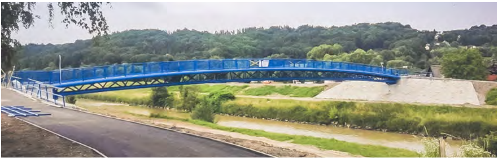
Lávka přes řeku Opavu - příjezd po cyklostezce od Kozmic.
