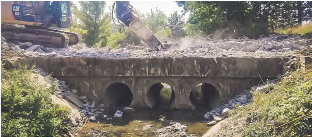
Demolice starého betonového propustu na „Juliánce“.
