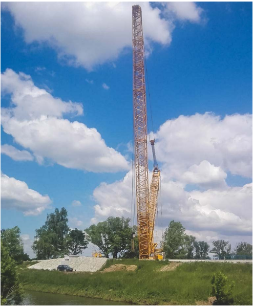
Levobřežní hráz - příprava podkladu.
