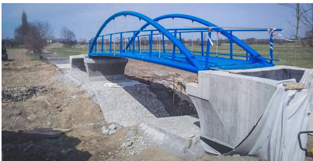
Lávka přes Juliánku - montáž ocelové části.
