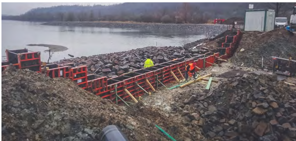
Funkční objekt - montáž bednění stabilizačního prahu.
