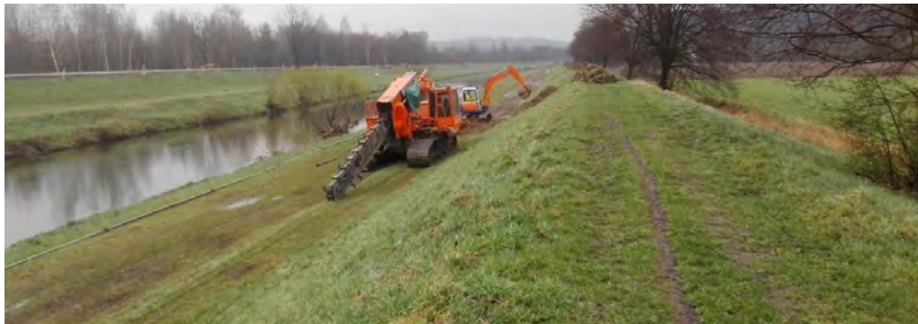
Pravobřežní hráz - technika pro provádění podzemní těsnicí stěny.
