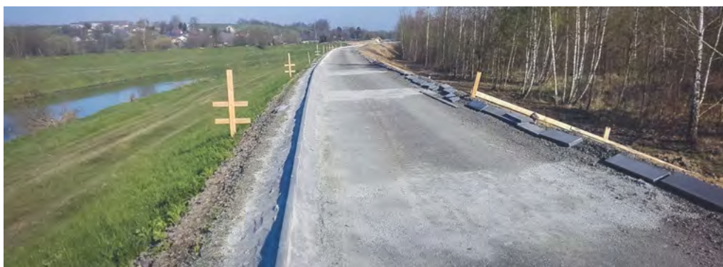
Levobřežní hráz - realizace komunikace na koruně hráze. Fota: Gardenline s.r.o.
