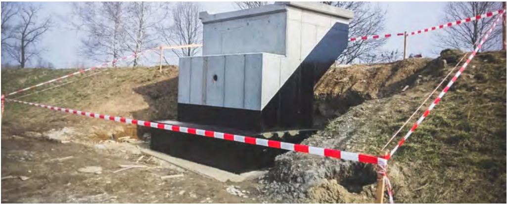
Lávka přes řeku Opavu - opěra 01.
