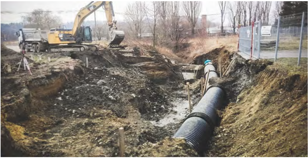
Úprava potoka Vařešinky - zatrubněná část.
