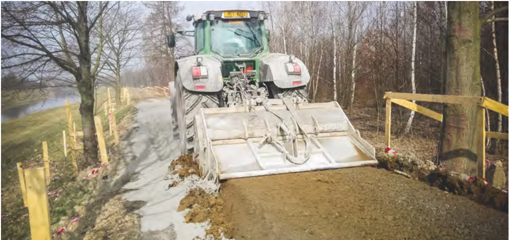
Levobřežní hráz - příprava podkladu. Fota: Gardenline s.r.o.
