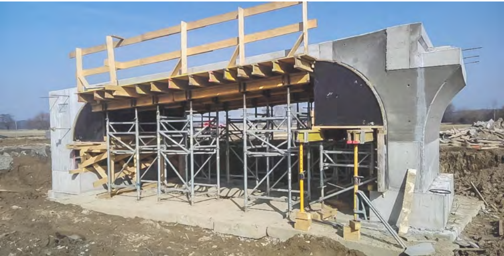
Lávka přes Juliánku - opěra 1
