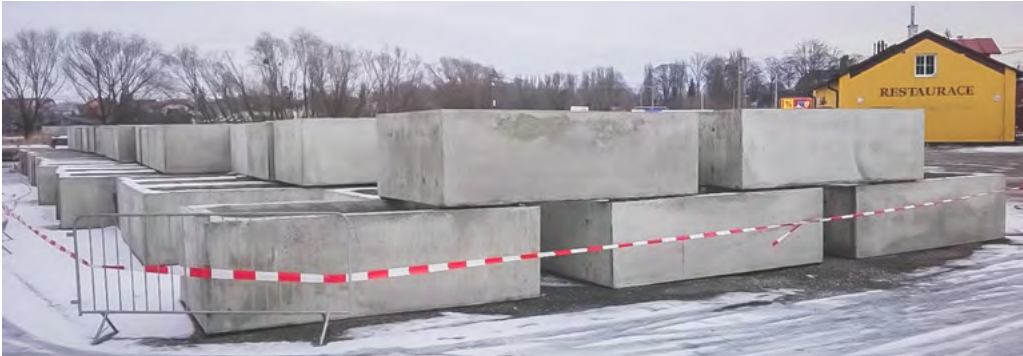
Návoz materiálu - betonové prefabrikáty pro zatrubněnou část Vařešinky
