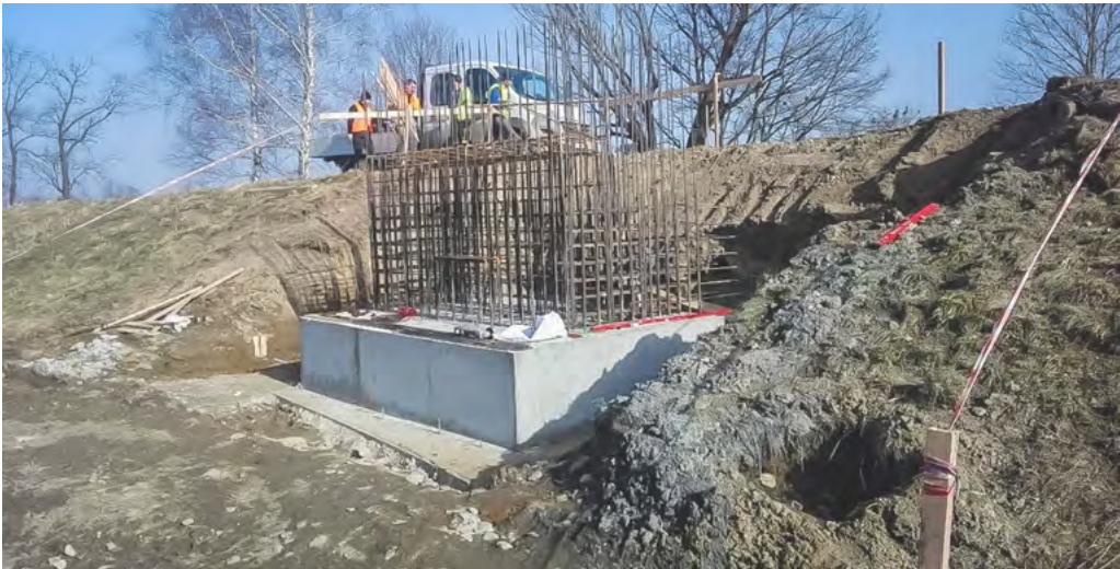
Lávka přes řeku Opavu - základové konstrukce. Fota: Gardenline s.r.o.
