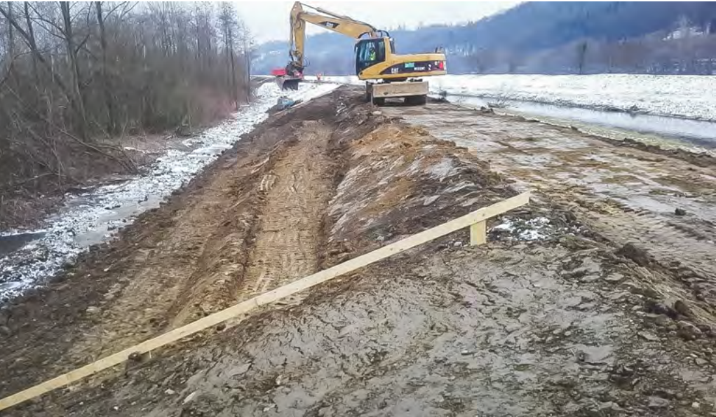
Levobřežní hráz kolem řeky Opavy - zemní práce
