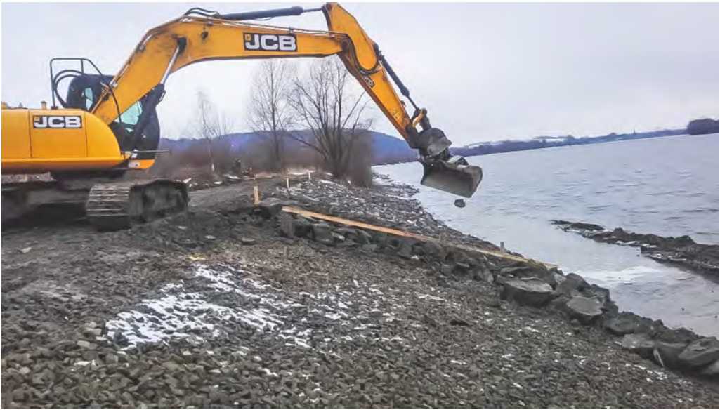
Úprava břehů - kamenný zához
