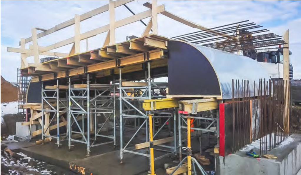
Lávka přes Juliánku - montáž armatury a bednění opěry 1 Fota: archiv Gardenline s.r.o.
