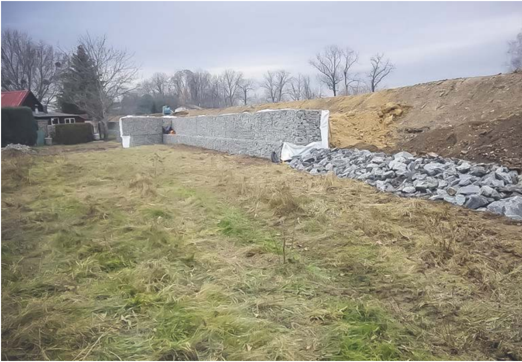
Rampa na pravobřežní hrázi - gabiony. Fota: archiv Gardenline s.r.o.
