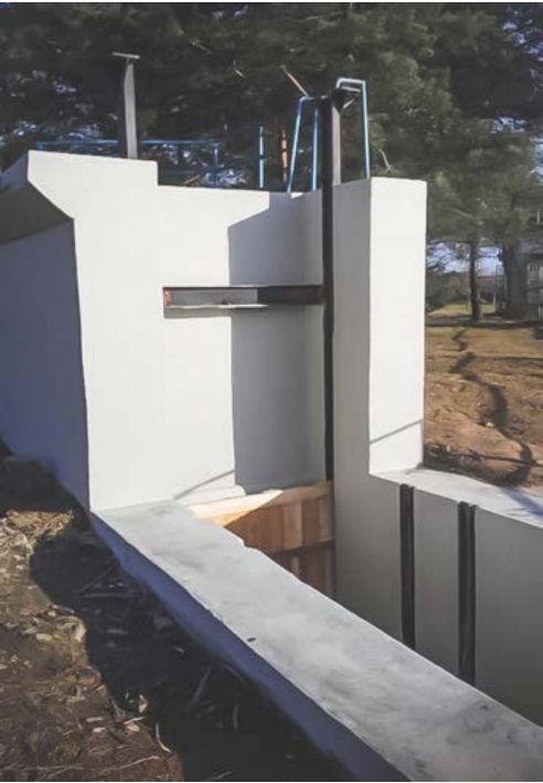
Napouštěcí objekt - sanace stávajícího objektu.
