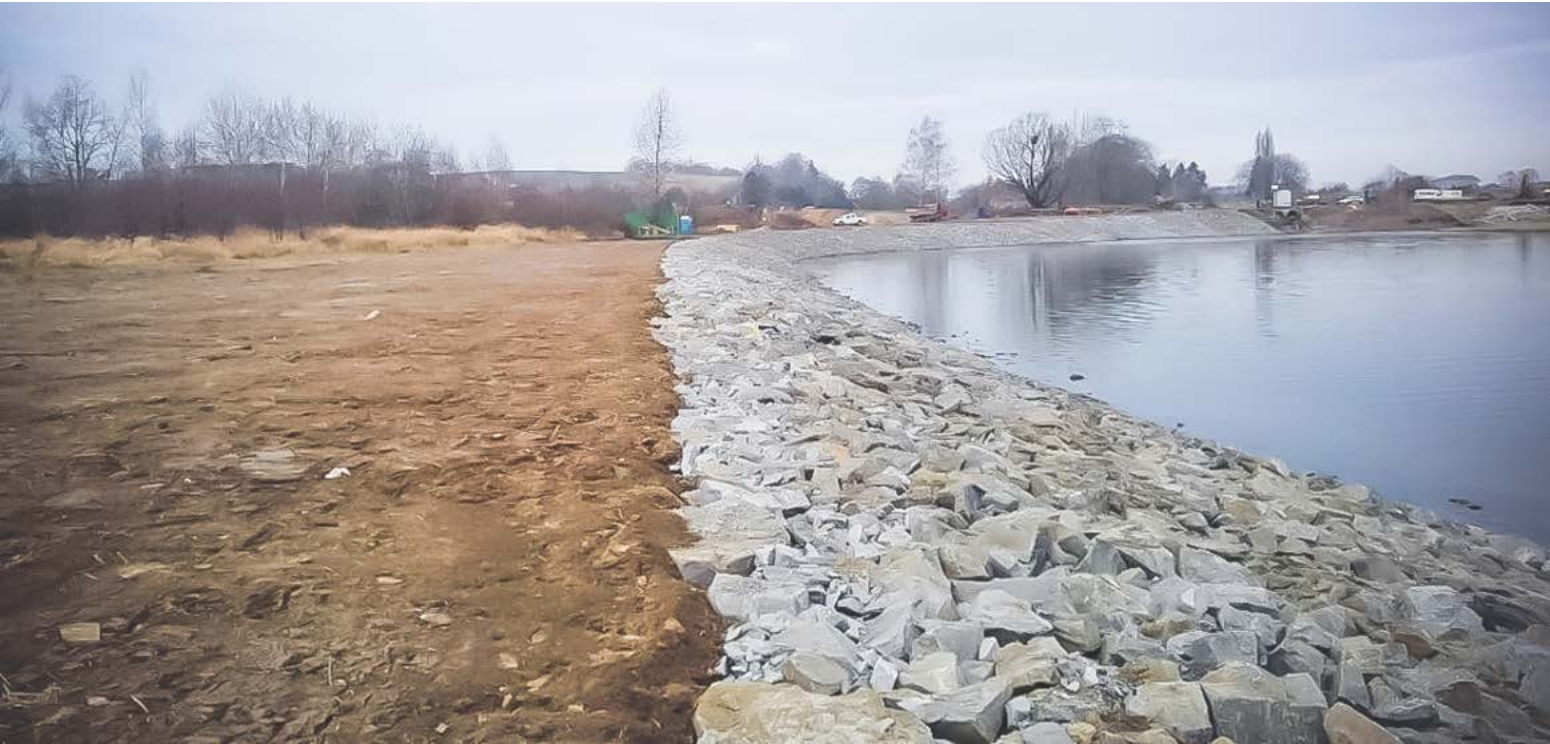
Kozmická zátoka - opevnění břehů - kamenný zához a úprava terénu.
