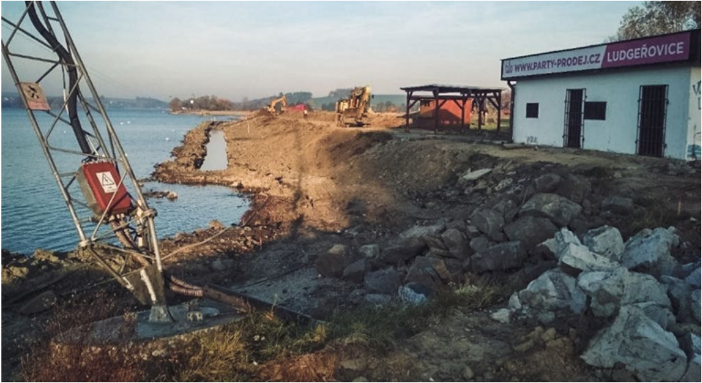
Areál šterkovny - úprava břehů kolem vleku na vodní lyžování. Fota: archiv Gardenline s.r.o.
