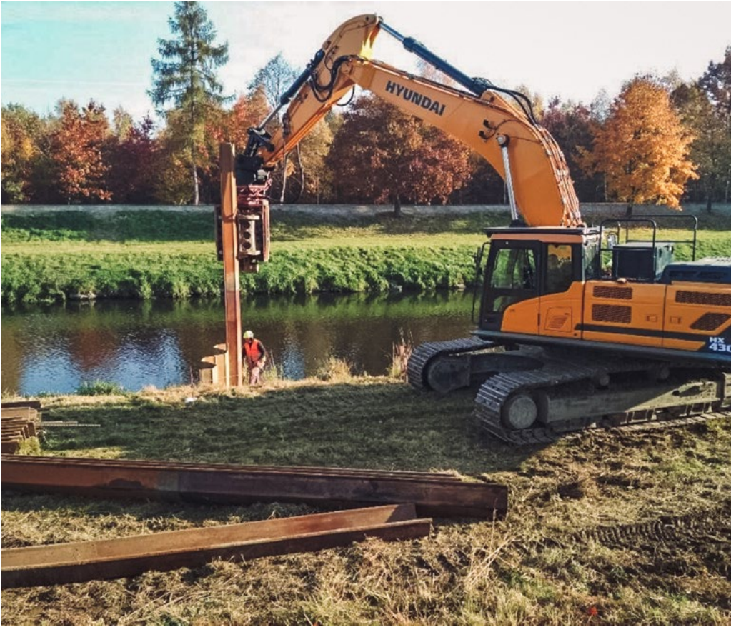
Pravobřežní hráz - montáž „štětovnicové stěny“ k realizaci propustku.
