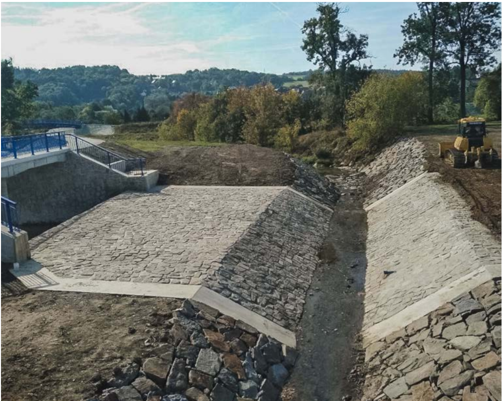
Funkční objekt a opevnění břehů potoku „Juliánka“. Fota: archiv Gardenline s.r.o.
