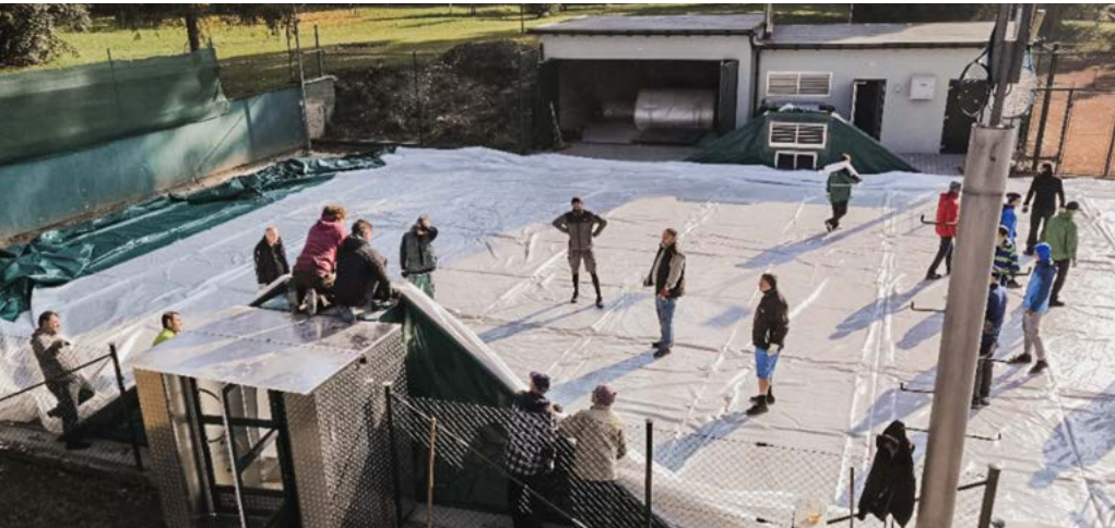
Stavba přetlakové haly. Foto: Martin Kučera
