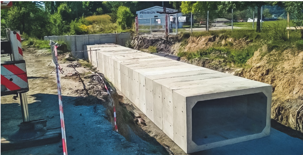
Zatrubněná část Vařešinky.
