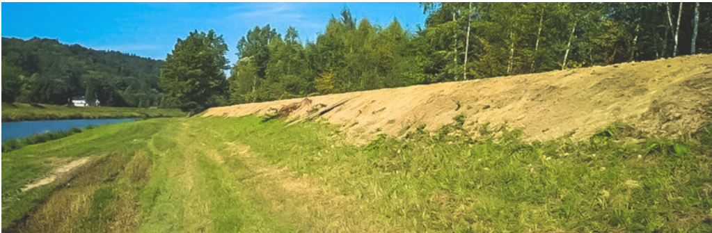
Levobřežní hráz. Fota: archiv Gardenline s.r.o.
