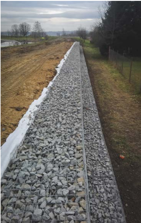
Pravobřežní hráz - gabiony.
