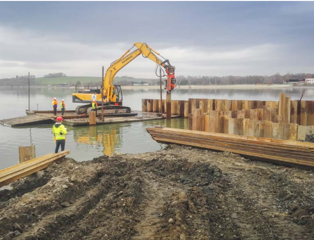
Bezpečnostní přeliv - zabezpečení stavební jámy štětovnicemi z pontonu. Fota: archiv Gardenline s.r.o.
