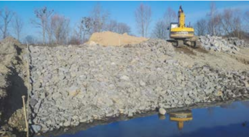
Kozmická zátoka - opevnění břehů, kamenný zához.
