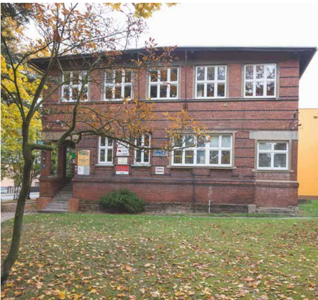
Současná podoba bývalé hornické nemocnice. Foto: Petr Gašpárek, 2015
