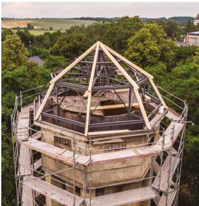
Nová střecha bude kopírovat původní vzhled. Foto: Kamil Vitásek
