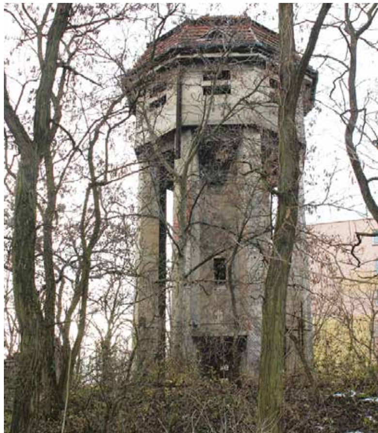
Vodárenská věž u železničního nádraží.
