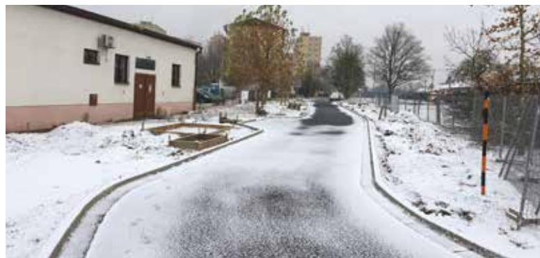
Příjezdová komunikace je hotova, stromy jsou přesazené. Foto: Petr Rončka
