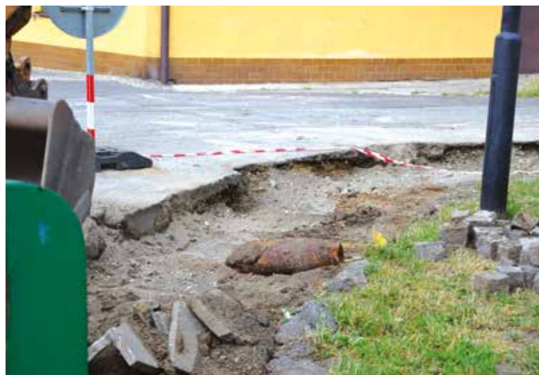
Leteckou pumu objevili stavbaři při hloubení příkopu.
