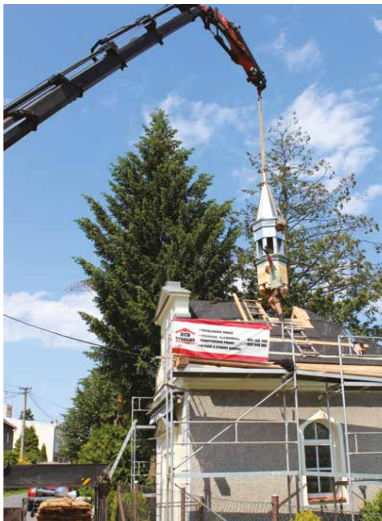
Společnost Red Střechy instalovala na kapli novou věžičku pomocí hydraulické ruky. Foto: Ivana Gračková
