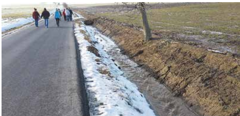
Vodu z tajícího sněhu odvádějí čerstvě vyčištěné příkopy.
