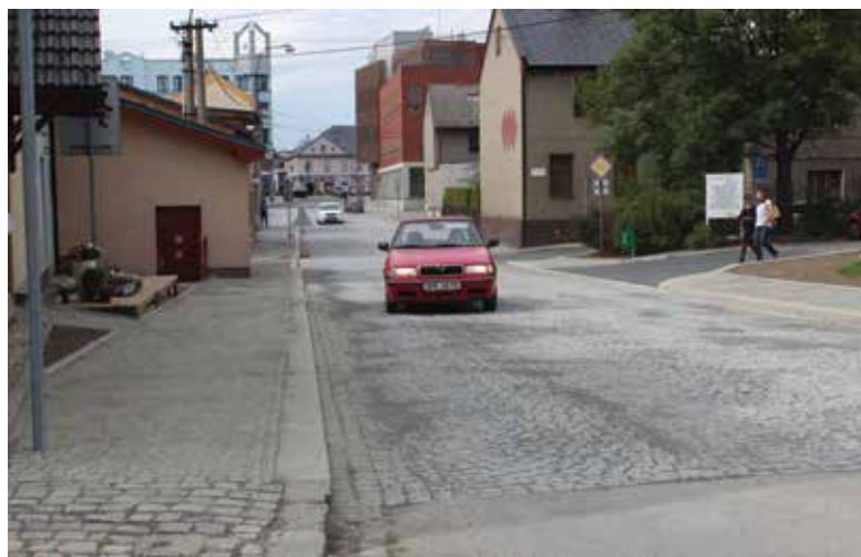
Stavbaři dokončili práci o týden dříve.
