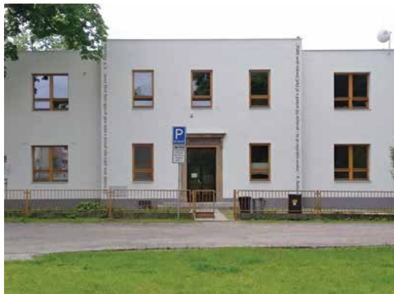
Také si půjdete přečíst, co je napsáno na fasádě domu dětí? Foto: vizualizace
