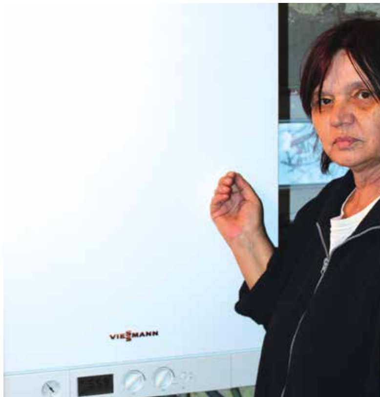
Moderní kondenzační kotel je uzavřený, oxid uhelnatý do obytných prostor z něj nemůže unikat. Foto: Ivana Gračková
