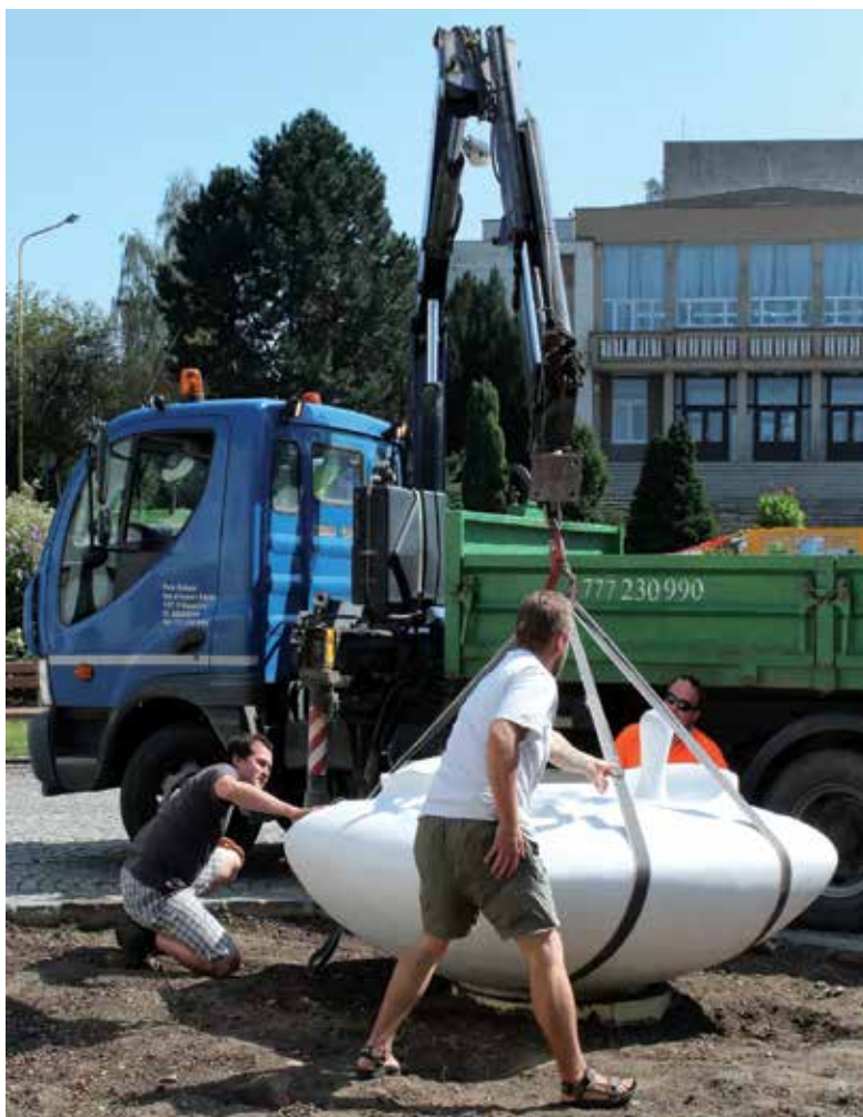
Socha se instalovala za pomoci těžké techniky.
