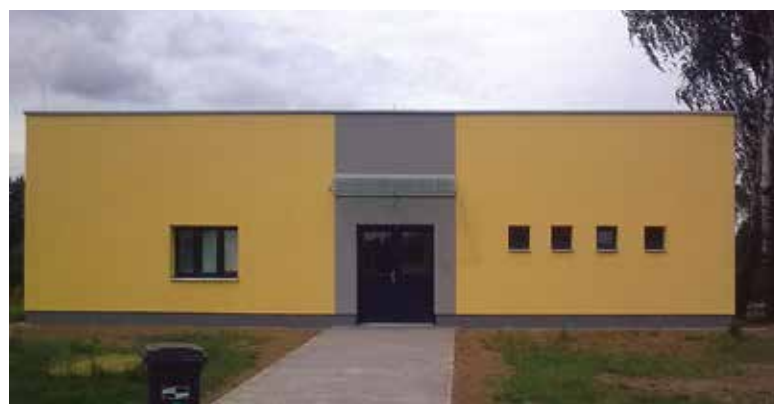
Objekt táborníků vypadá po opravě fasády příjemně.
