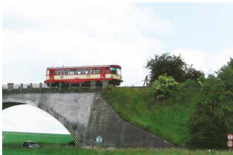
Železniční most v Hlučíně v červnu 2006.
