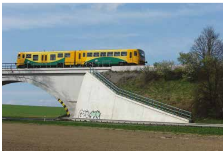
Železniční most v Hlučíně v květnu 2015.
