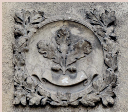
Štukový reliéfní kartuše se znakem spolku Nordmark na fasádě Kudlichova domu, stav v roce 2015.
